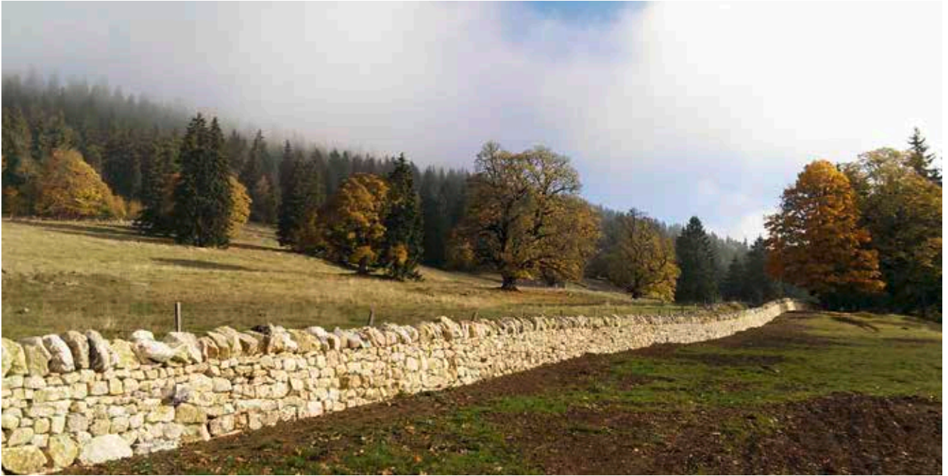
Mur de clôture en pierres sèches dans le Parc du Chasseral dans le Jura bernois
