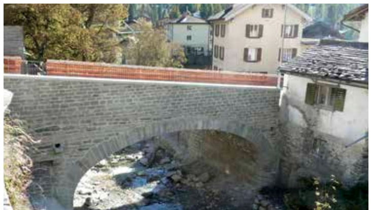
La remise en état de 2017 a permis de restaurer le mur de parapet d'origine du pont de Safierbach.
