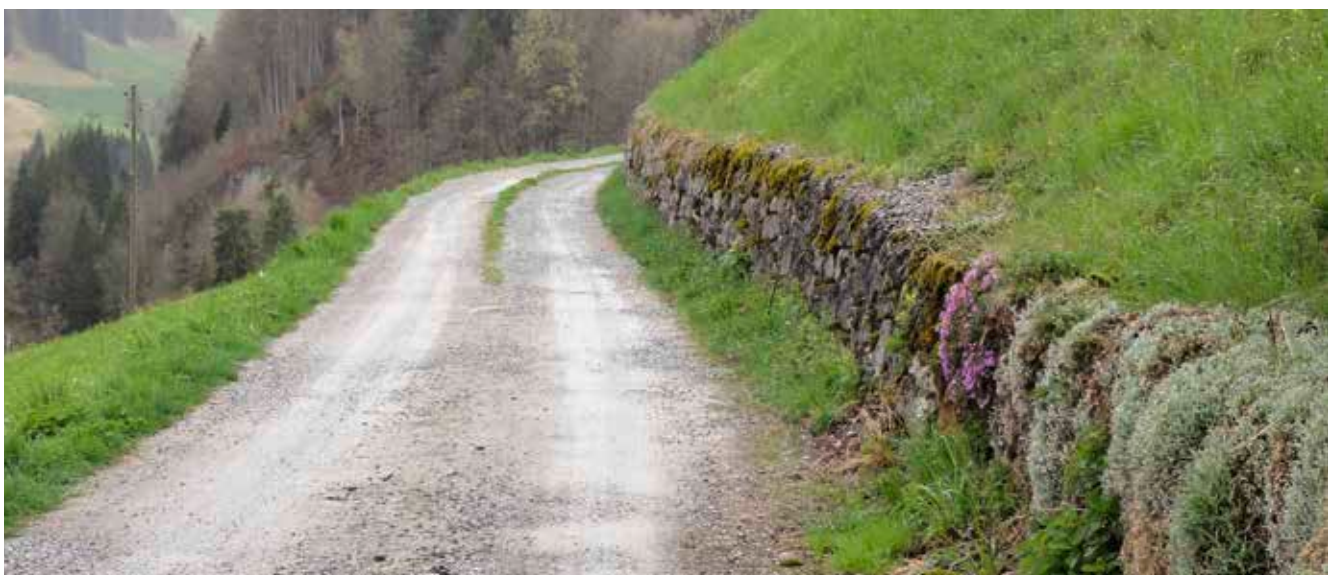
Le gravier en tant que revêtement: chemin rural de Wüstenbach-Seeweide remis en état dans le canton de Berne.
