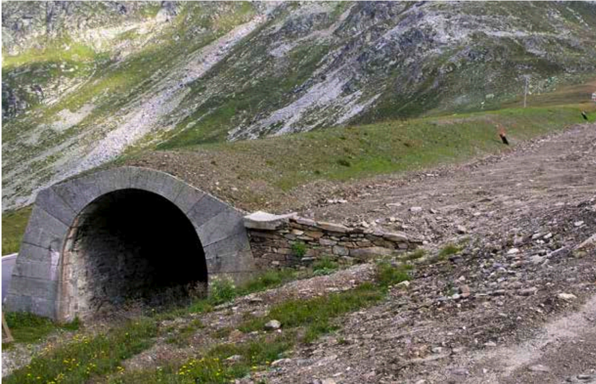
La galerie paravalanche du col du Splügen est le dernier ouvrage de ce type à avoir été conservé.
