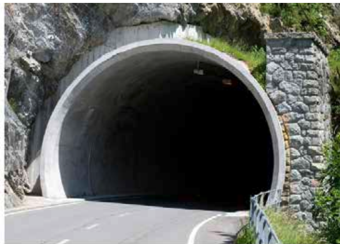
Esquisse de planification et réalisation du portail aval remis en état du tunnel de Wiler au col du Susten
