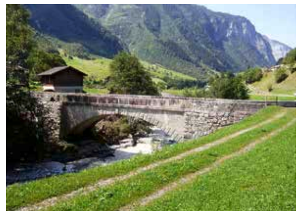
Mur de parapet maçonné sur le Bodenbrücke dans le canton de Berne.
