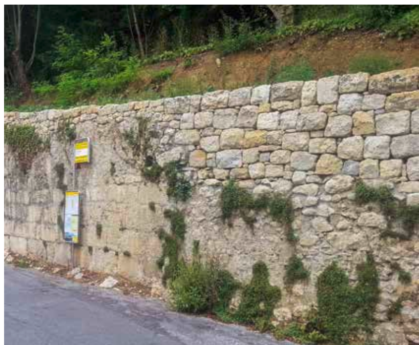
La consolidation du mur de soutènement historique de Romainmôtier après l'effondrement (à gauche) et après la remise en état selon la méthode traditionnelle (à droite).
