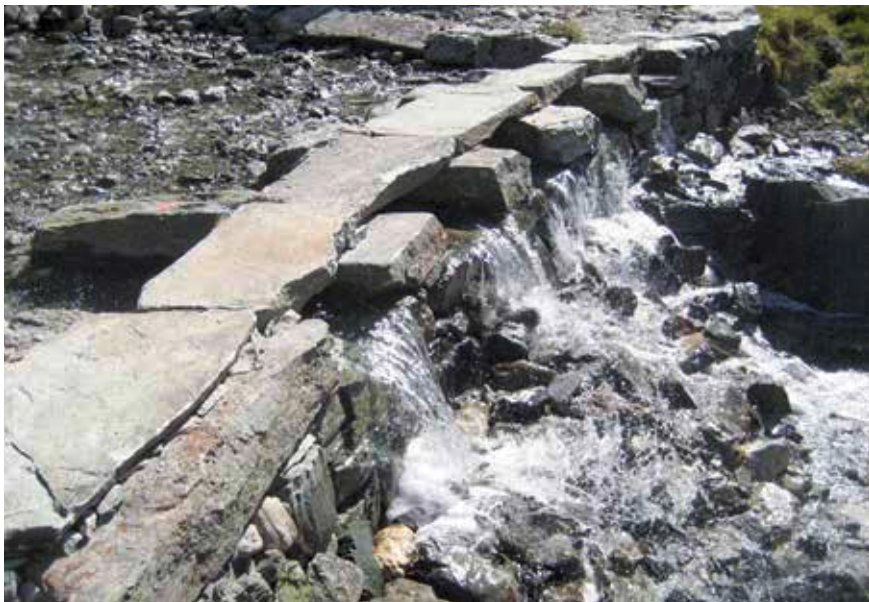
Passerelle pour ruisseau en pierres taillées sur le chemin muletier historique du col du Septimer.
