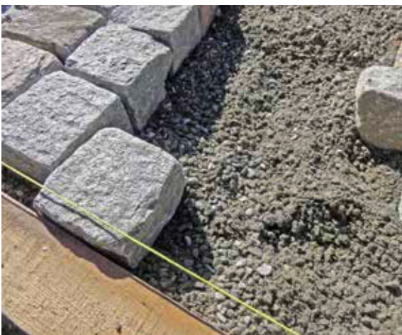
Mise en place de pavés sur la route italienne sur une couche de sable/de gravillons (en haut). État de la route italienne après les travaux de remise en état, avec le nouveau pavage en arc et la bande centrale en pavés rougeâtres (à droite).
