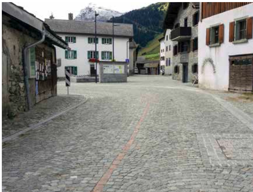
Mise en place de pavés sur la route italienne sur une couche de sable/de gravillons (en haut). État de la route italienne après les travaux de remise en état, avec le nouveau pavage en arc et la bande centrale en pavés rougeâtres (à droite).
