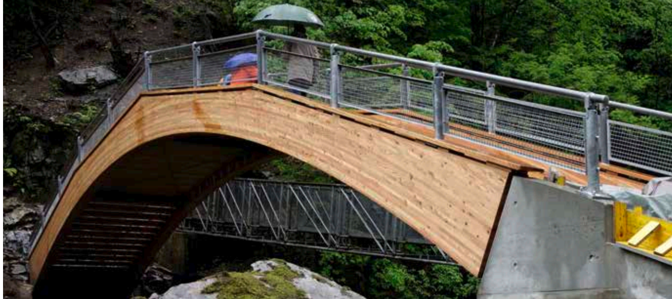
Pont en arc sur l'Isorno d'après les plans de Christian Menn lors des travaux de construction.
