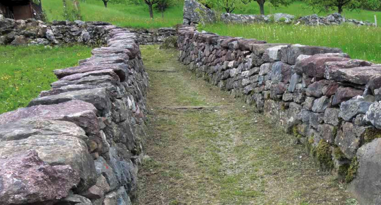
Mur de pierres sèches sur la route historique d'Ennenda à Uschenberg (canton de Glaris).
