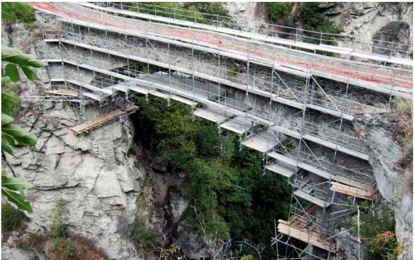
Mise en place d'un échafaudage sur le Chibrücke avec appui sur les piliers du pont.
