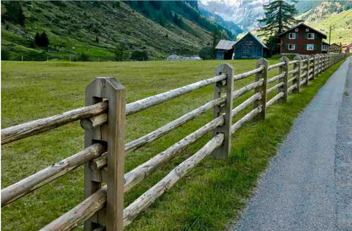
Les clôtures en bois font naturellement partie du Meiental. Leur remise en état suit la méthode de construction traditionnelle.
