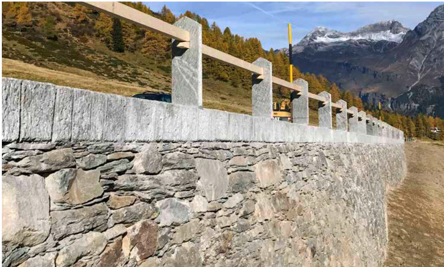
Mur de pierres sèches près du pont de marbre au col du Splügen.
