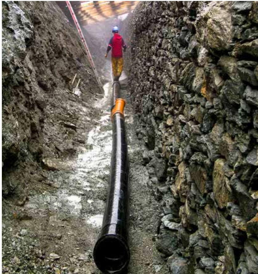
L'évacuation des eaux, ici un nouveau tuyau de drainage, est d'une importance cruciale pour la durabilité de la galerie du Splügen.
